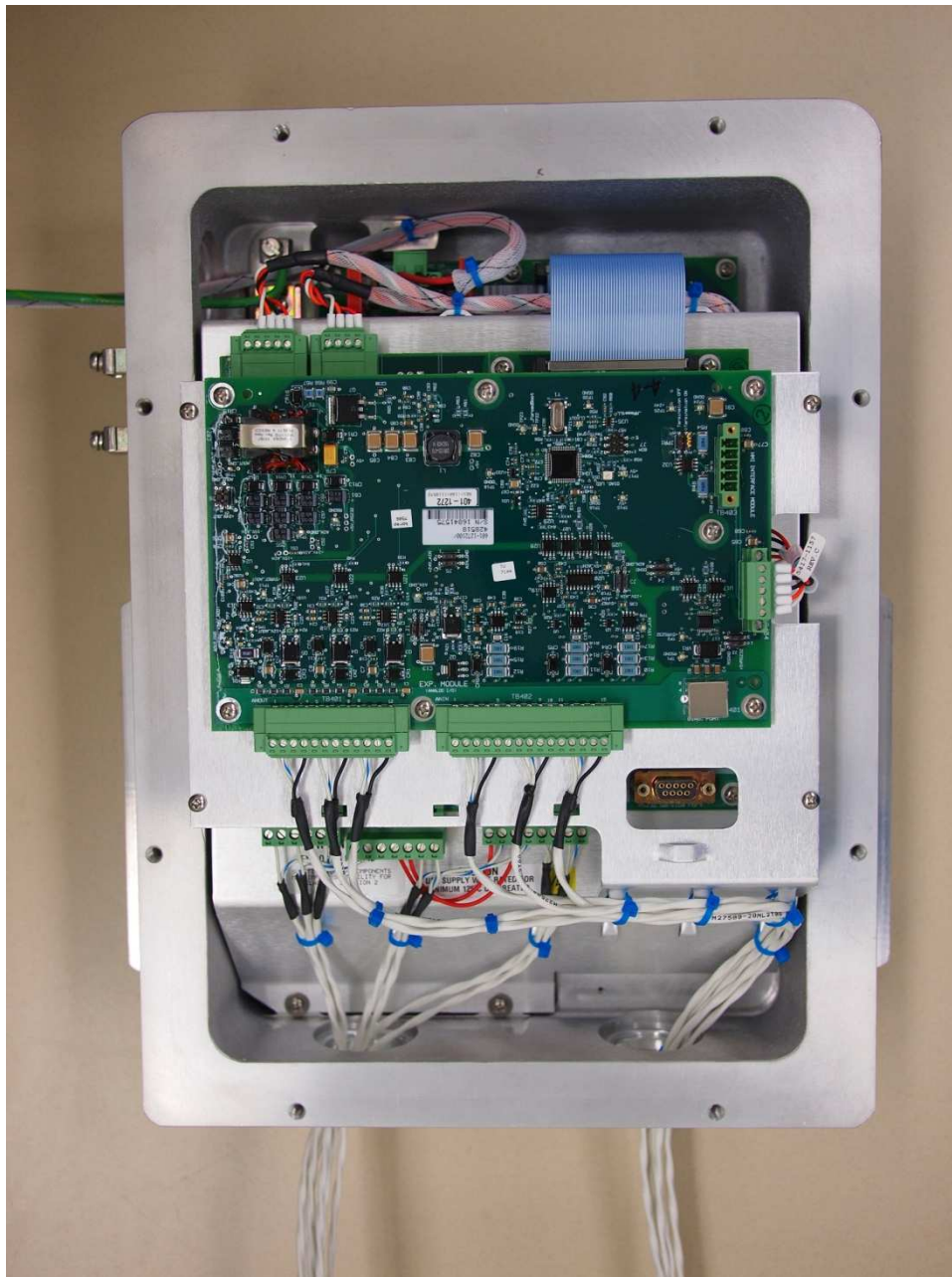
Illustration 2-16. Entrée du conduit de pilote
