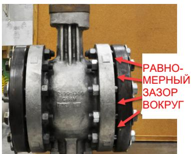
Рисунок 2–3. Равномерный зазор между фланцами
