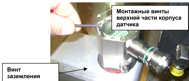
Рисунок 4–1б. Замена датчика SIL2
